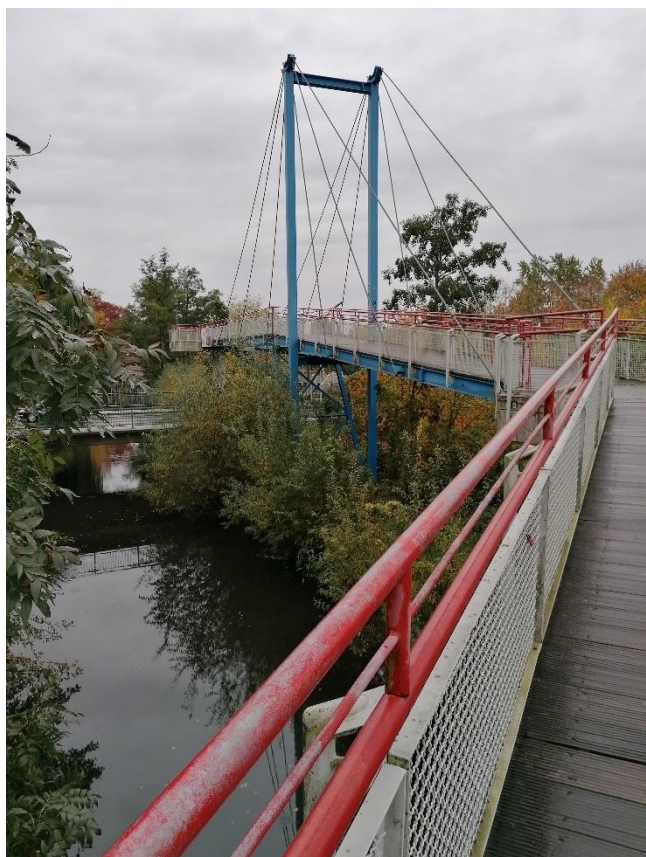
Die Oldenzaal-Brücke in Rheda-Wiedenbrück
